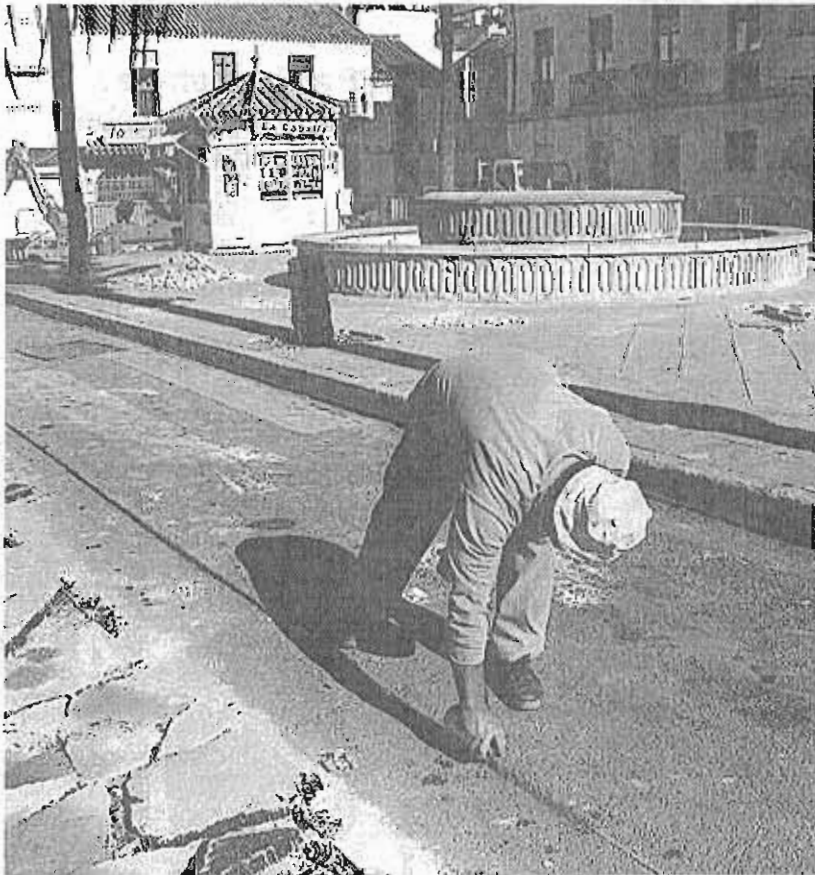
Las empresas de construcción son las que más están sufriendo los impagos de las administraciones. ... sur
