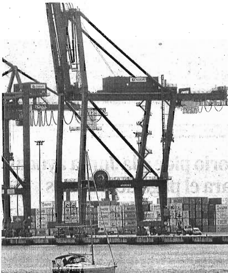
Muelle de contenedores, en el que se detectaron las últimas irregularidades en la ejecución de las obras.
