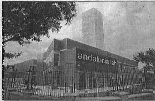
Fachada principal del centro Andalucía Lab. ARCINIEGA
