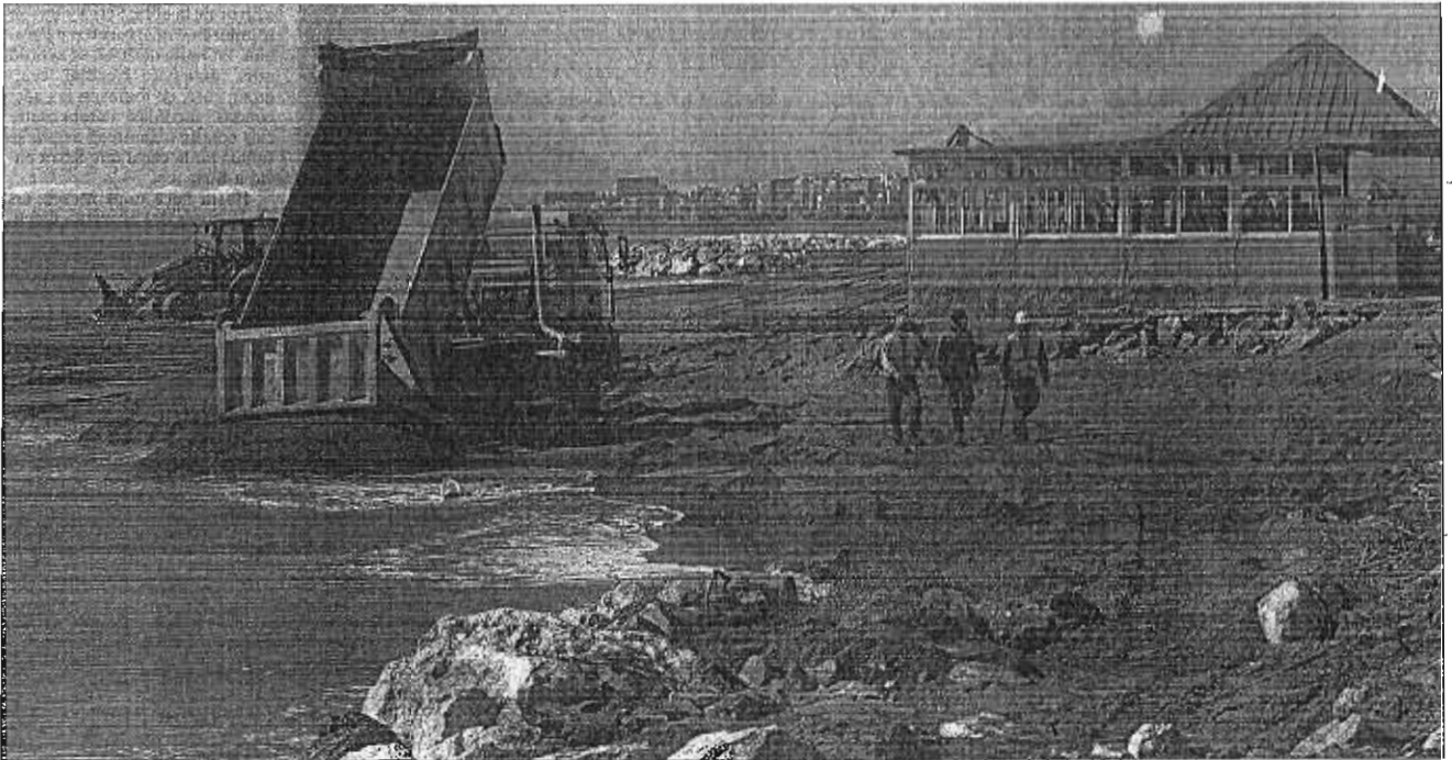
Reposición de arena en la playa de Guadalmor (Málaga). / GARCÍA-SANTOS
