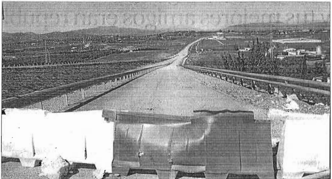
Actual estado del nudo de enlace Coín-Casapalma, que debía haberse finalizado en 2009. RODÍO CAÑADA
