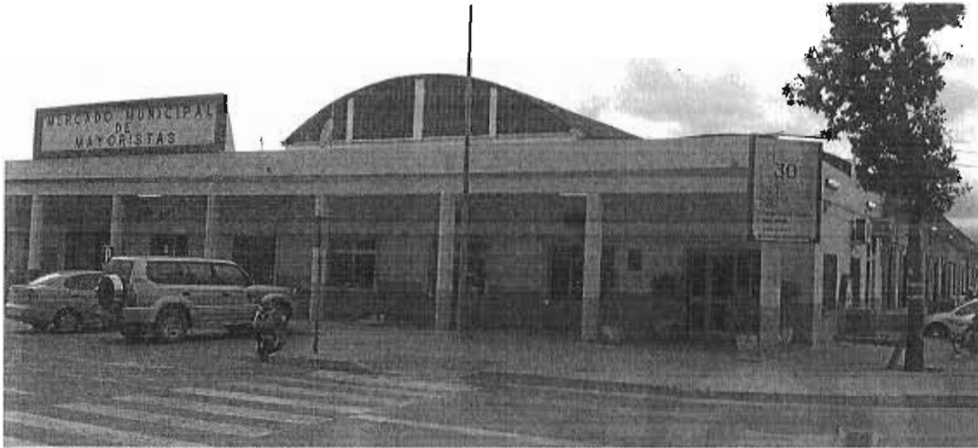
El Ayuntamiento es propietario del viejo edificio del mercado de mayorista, que cuenta con otra nave anexa de titularidad privada. :: A. PELÁEZ
