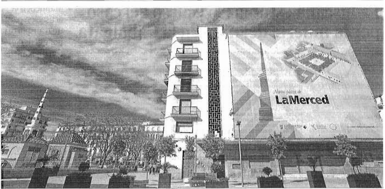
Vista de la fachada sur del Astoria y de la Plaza de la Merced.
