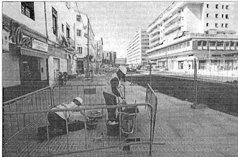
Operarios trabajan en las obras del metro a su paso por los Callejones del Perchel. ARCHIMEA
