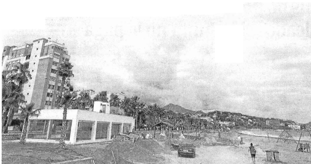
Un chiringuito en construcción en la playa de La Caleta de Málaga hace un mes.
