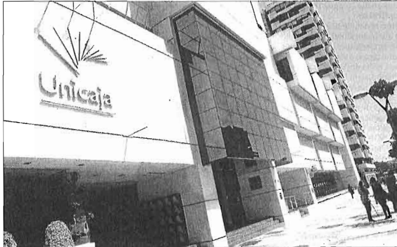
Vista de la sede central de Unicaja, situada en la avenida de Andalucía. ARCINIEGA
