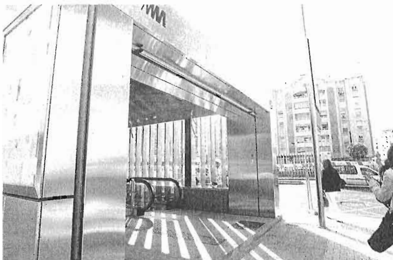
Puerta Blanca es una de las estaciones que se encuentran ya terminadas en el trazado. ■ SALVADOR SALAS
