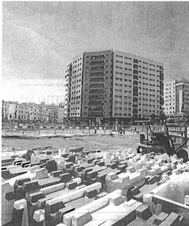
Zona de obras en la Plaza de Albert Camus.
