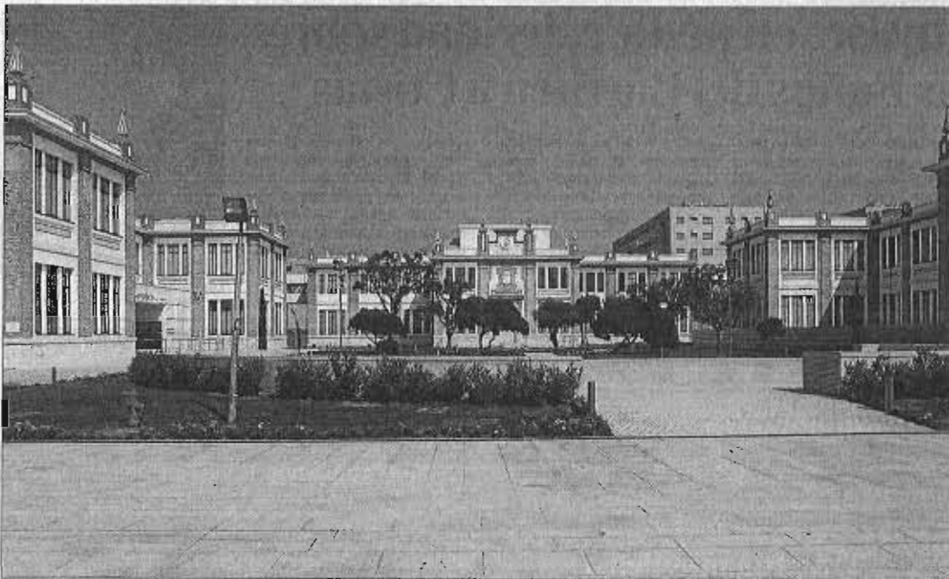
Los edificios históricos de Tabacaleras, prácticamente rehabilitados y a la espera de una decisión sobre su ocupación. - ARCHIVESA
