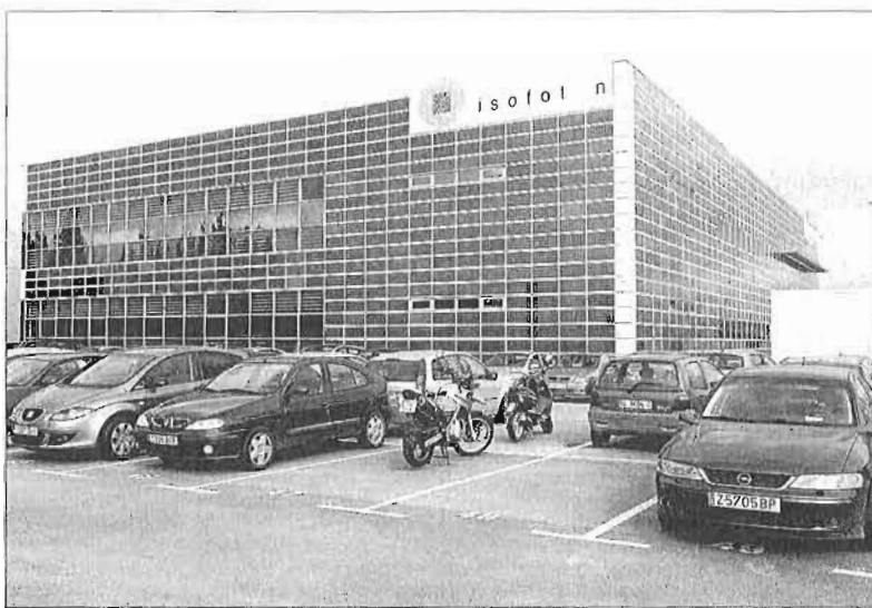
La sede de la empresa Isofotón, en el PTA de Málaga. ARCINEGA
