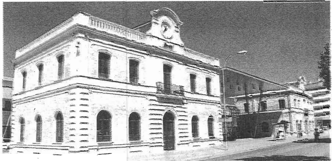
Los dos edificios históricos permanecen vacíos desde su rehabilitación. :: SUR
