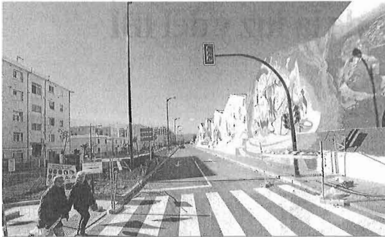
Estado actual de la obra del bulevar sobre el soterramiento del AVE.
