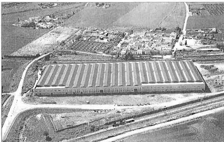
Imagen del Centro Integral de Servicios Ferroviarios vinculado al anillo, ya construido en Antequera. L. O.
