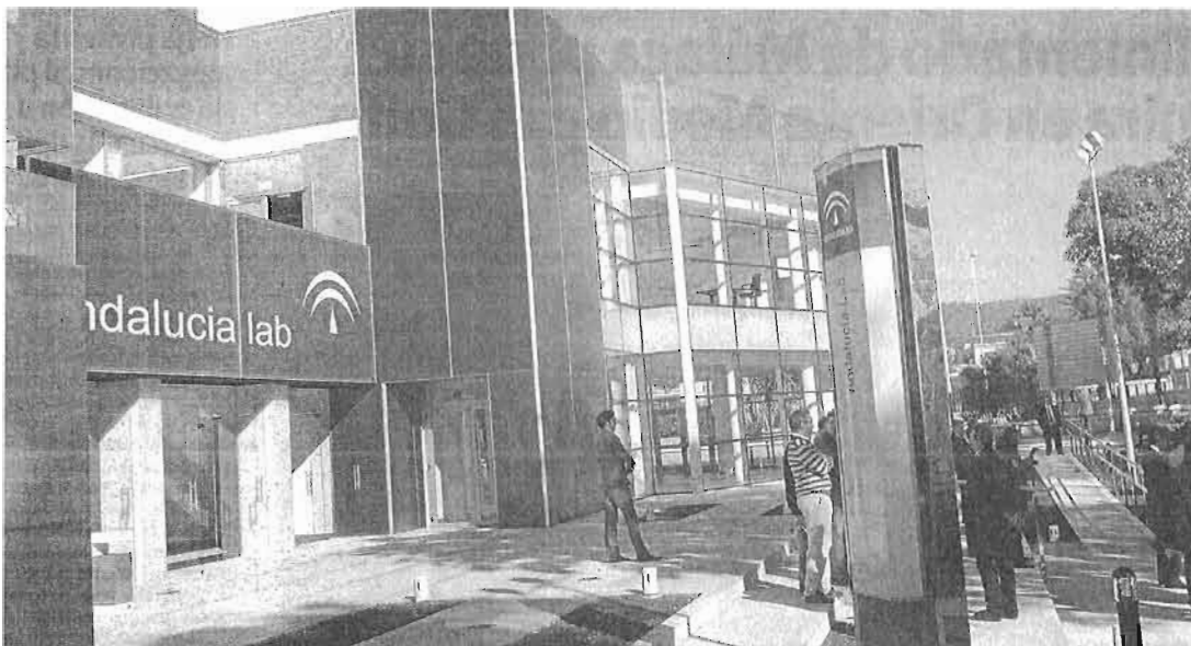
Instalaciones del Andalucía Lab en Marbella. :: JOSELE-LANZA
