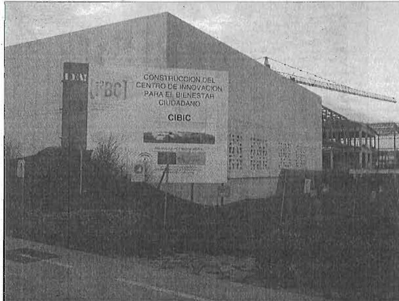
Obras de construcción del edificio destinado a acoger el fallido proyecto de I2BC en el PTA. / EL MUNDO
