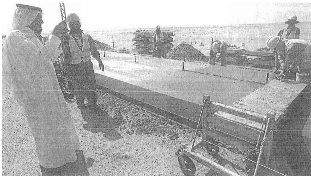
Un responsable del Gobierno de Arabia Saudí visita un tramo de la línea de alta velocidad entre La Meca y Medina. :: ADIF
