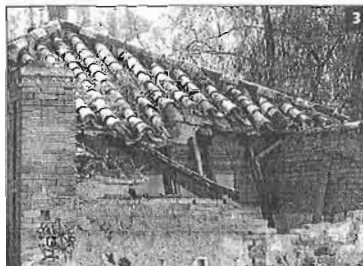
► RADIOGRAFÍA DE LA DEJADEZ. Son cuatro imágenes, pero se podrían mostrar más. 1 La fachada de entrada al balneario con serio peligro de desprenderse. 2 Columnas rotas y techumbres al aire. 3 La teja malagueña ya será difícil de reponer. 4 Techumbre deteriorada y cables al aire. © G. TORRES
