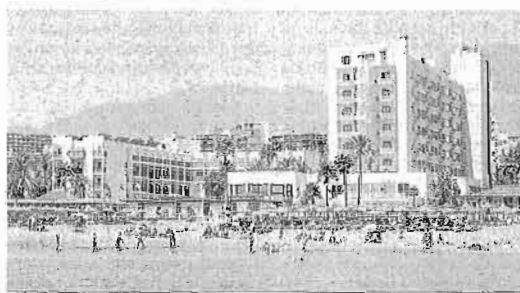
Vista desde el mar del hotel Pez Espada en Torremolinos.
