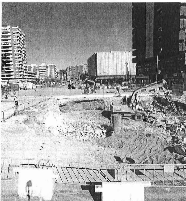
Imagen de archivo de las obras de construcción del Metro de Málaga.
