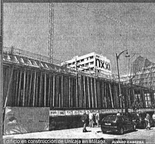
Edificio en construcción de Unicaja en Málaga. ALVARO CABRERA
