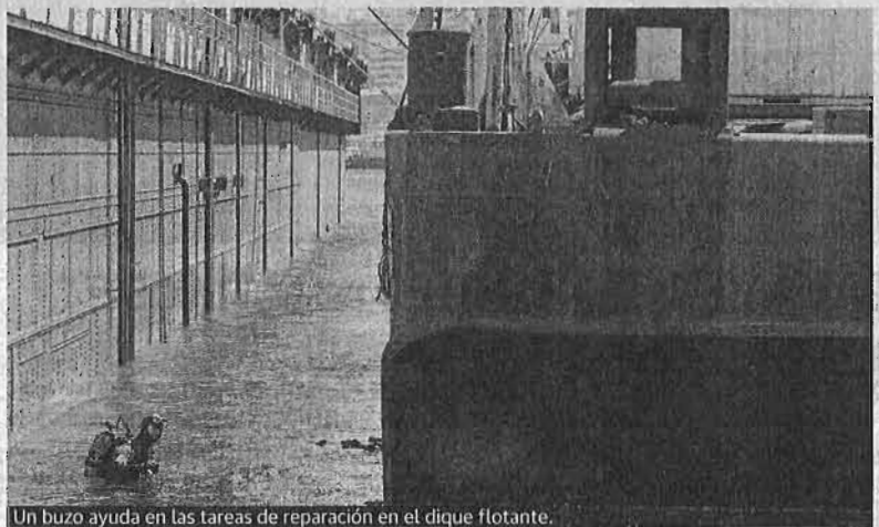
Un buzo ayuda en las tareas de reparación en el dique flotante.
