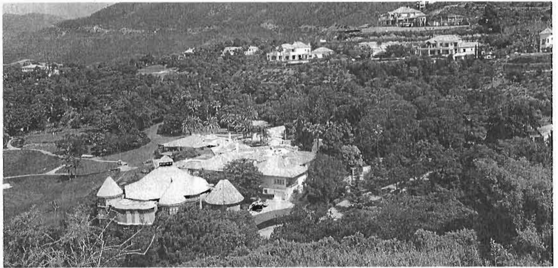
Viviendas en La Zagaleta, urbanización de lujo que se encuentra en Benahavís. :: JOSELE-LANZA
