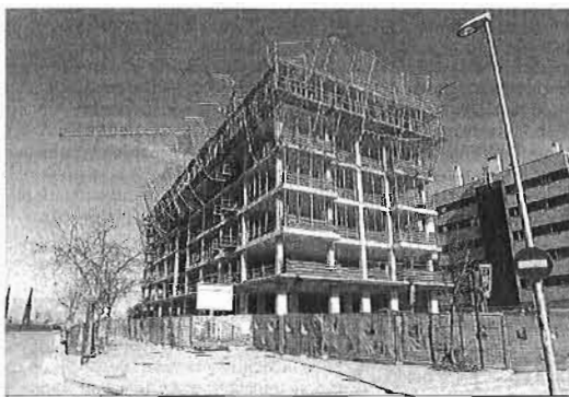
Pisos en construcción.
