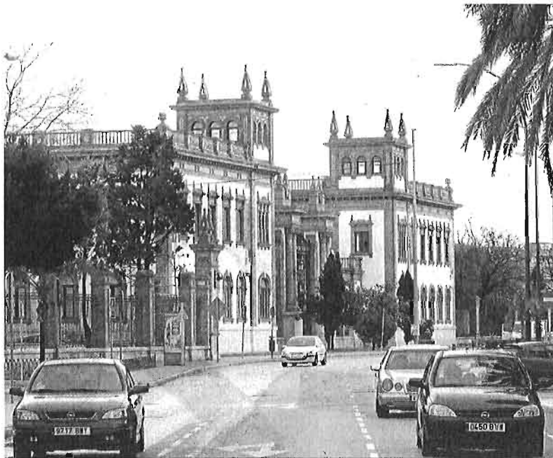
Vista de las Instalaciones de Tabacalera.
