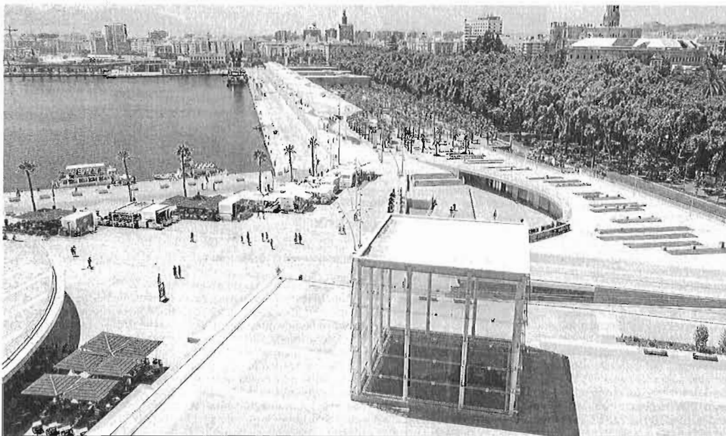
Imagen del Cubo, que se levanta en la esquina de los muelles 1 y 2 del puerto de Málaga.
