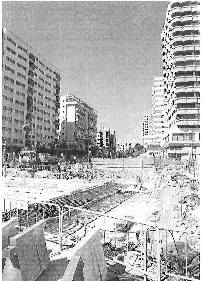
Obras del Metro en la glorieta Albert Camus.
