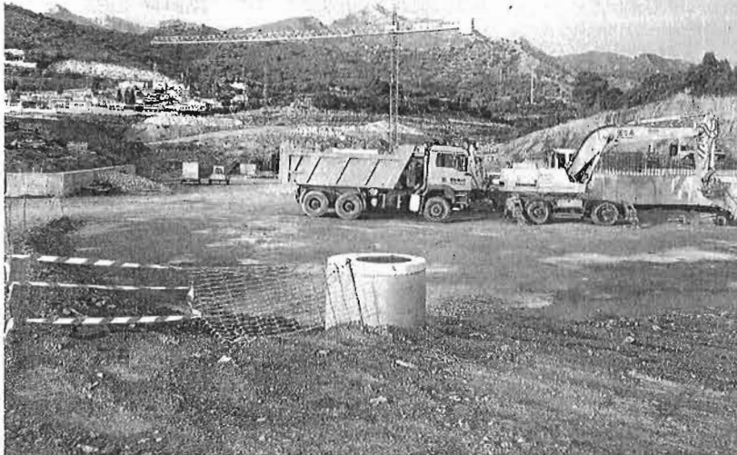
Imagen del estado de las obras de la EDAR de Nerja en la parcela de Aguahierro, ayer por la tarde. :: E. CABEZAS
