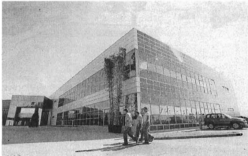
Evitar la degradación de las instalaciones y la maquinaria está suponiendo un alto coste. :: SUR
