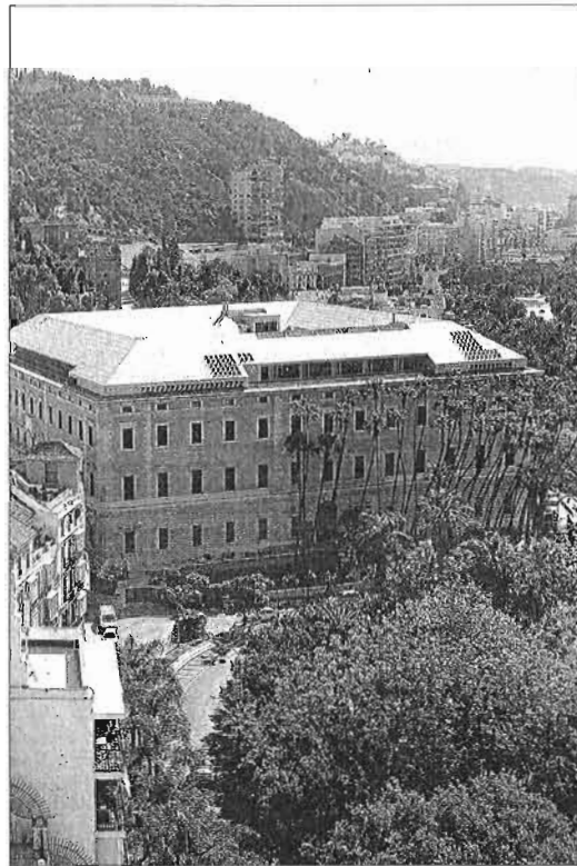
El Palacio de la Aduana podrá abrir a final de 2015. ARCINIEGA
