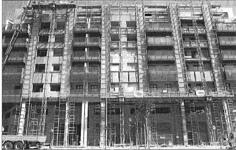
Edificio en construcción en Málaga capital. EL MUNDO
