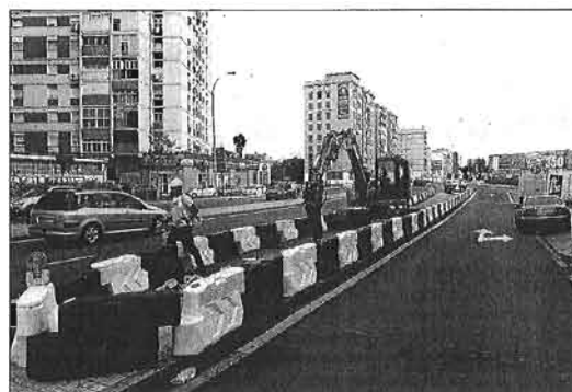
Obras en la avenida Juan XXIII. ARCINIEGA
