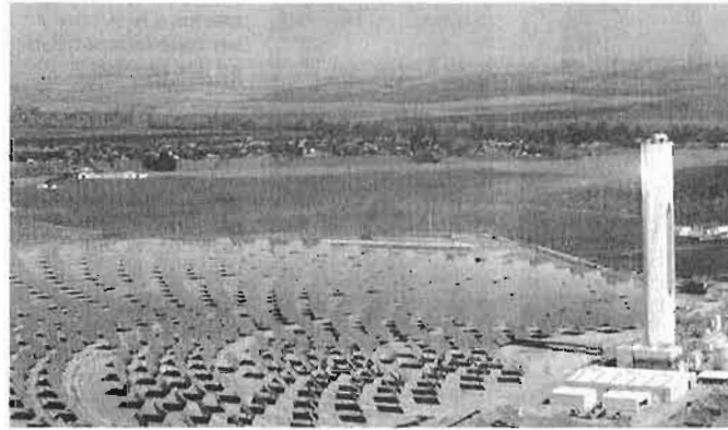
Planta solar de Sotilúcar de Abengoa, en Santilúcar la Mayor, Sevilla.
