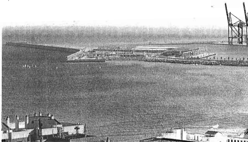
Plataforma del Dique de Levante, donde se ha previsto construir el rascacielos. :: ALVARO CABRERA
