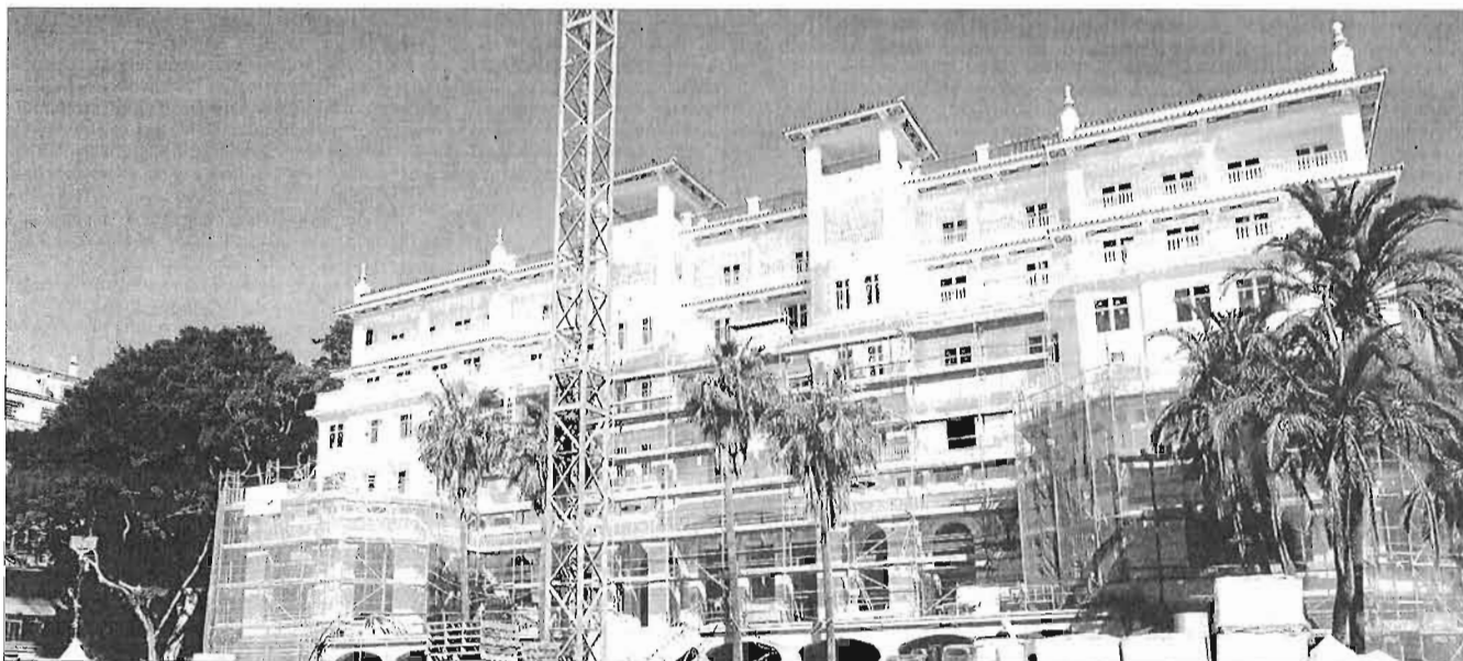
La fachada en obras del hotel Miramar, que abrirá sus puertas como establecimiento de cinco estrellas tras el verano. GREGORIO TORRES
