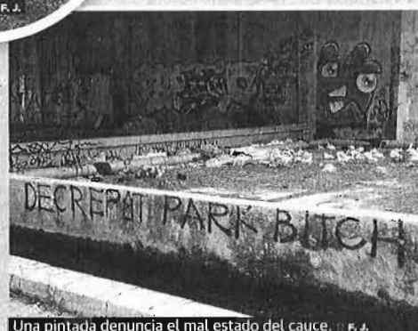
Una pintada denuncia el mal estado del cauce. F. J.
