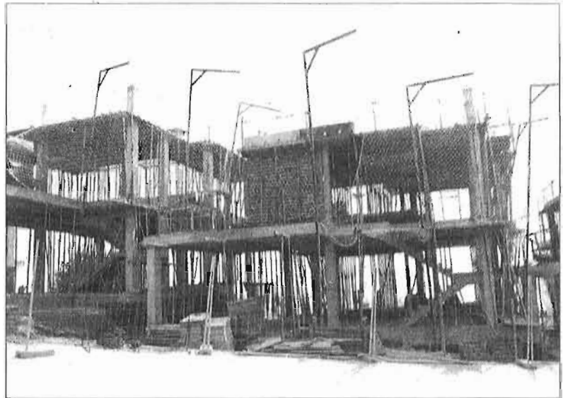
Viviendas en construcción en Málaga. EL MUNDO
