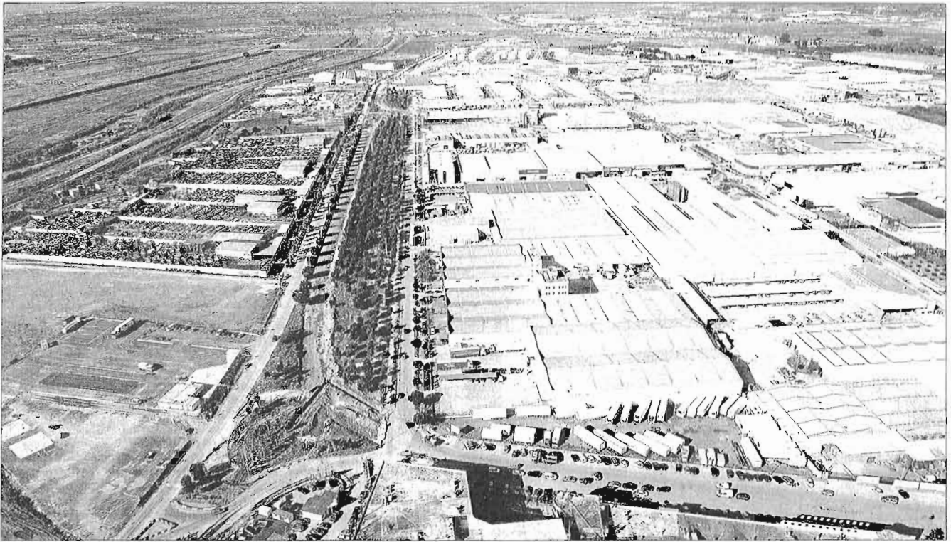
El sistema de videovigilancia se instalará en los tres grandes polígonos de la capital malagueña. GREGORIO TORRES
