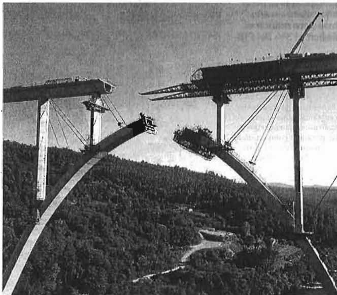
Obras de construcción de un viaducto.
