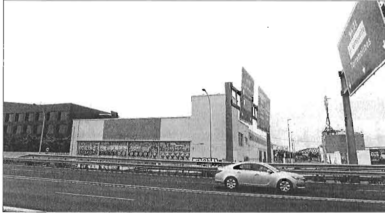
La nueva fábrica de Cerveza Victoria se instalará en la avenida Velázquez. ALEXEZA
