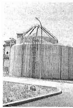
Depuradora del Guadalhorce.
