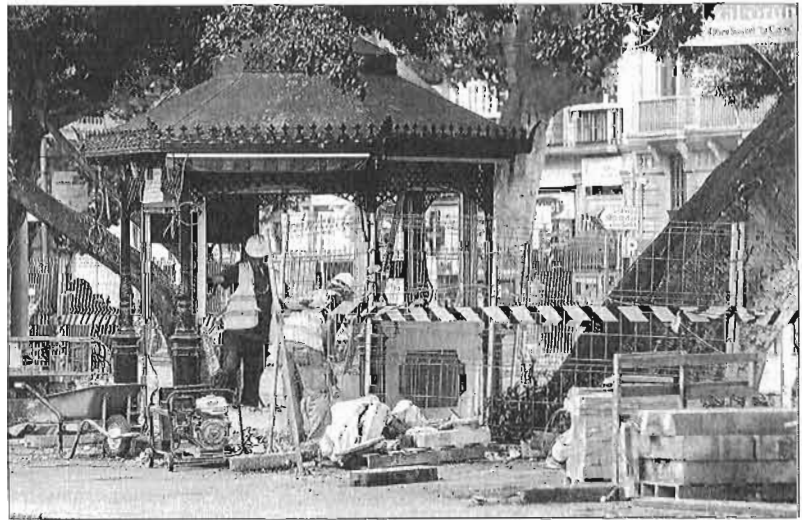
Los trabajos de construcción del metro en la Alameda han cortado el lateral norte. L.O.
