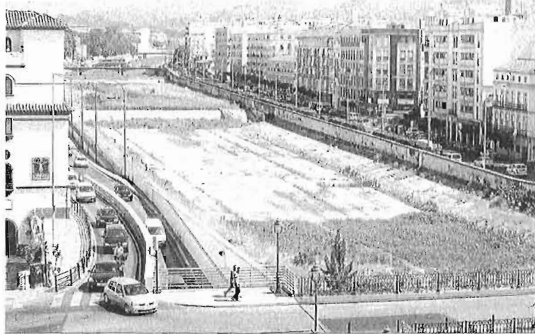
Cauce del río Guadalmedina en su desembocadura.
