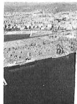
La terminal del muelle 9.
