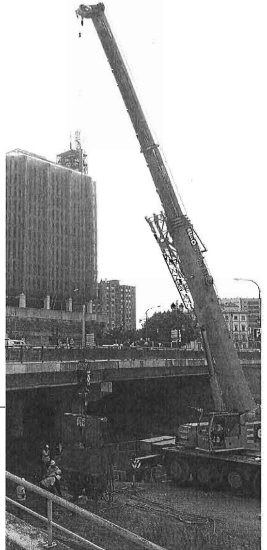
Trabajos de excavación en el cauce del Guadalmedina. :: ALVARO CABRERA
