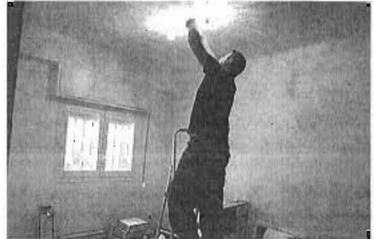
Un operario coloca una lámpara en uno de los pisos. :: A. CABRERA
