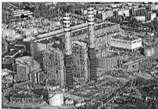
Central eléctrica en Algeciras.
