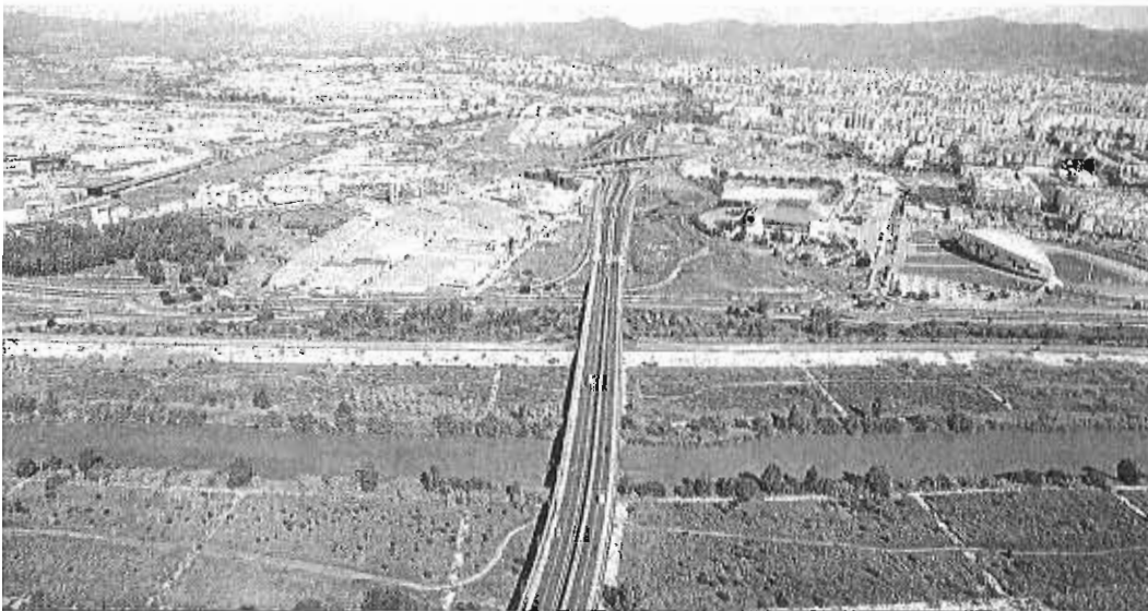
Imagen del río Guadalhorce y del puente que lo cruza.
