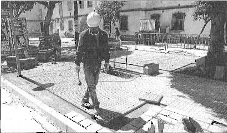
Obras en el distrito de Carretera de Cádiz. ARCI/MEGA
