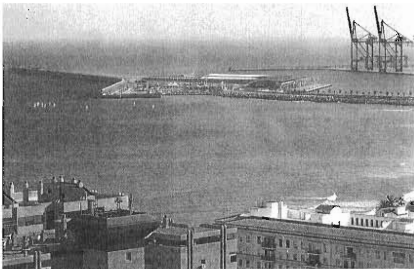
Vista del dique de Levante, donde se prevé ejecutar el proyecto. :: ALVARO CABRERA
