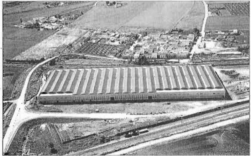
Imagen del Centro de Servicios Ferroviarios construido para el anillo ferroviario de Antequera. 10
