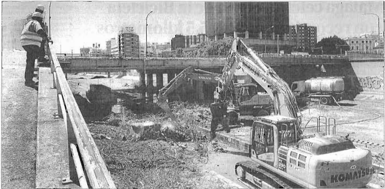
La obras de demolición del puente de Tetuán, que se iniciaron a finales de agosto dentro del proyecto del metro. GREGORIO TORRES
