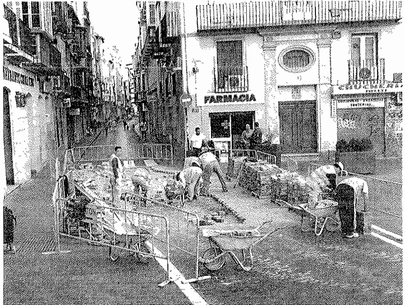
Trabajos de remodelación de la plaza de la Merced que en 2012 cortaron al tráfico la calle Álamos. // SUR
