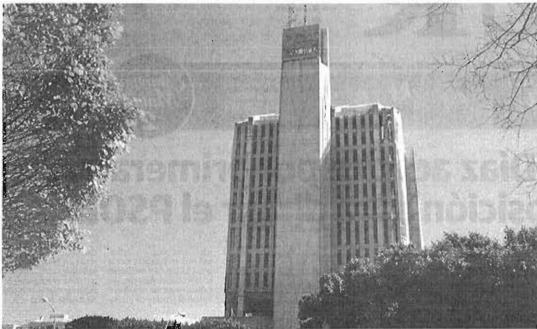
Vista del edificio de Correos, cerrado, cuyo cambio de uso, de administrativo a hotelero, negocia la Junta con el Ayuntamiento de la capital. :: sur
