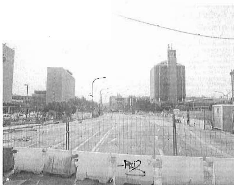
Vista de la Avenida de Andalucía, donde la obra del Metro está inactiva desde hace más de un año.
